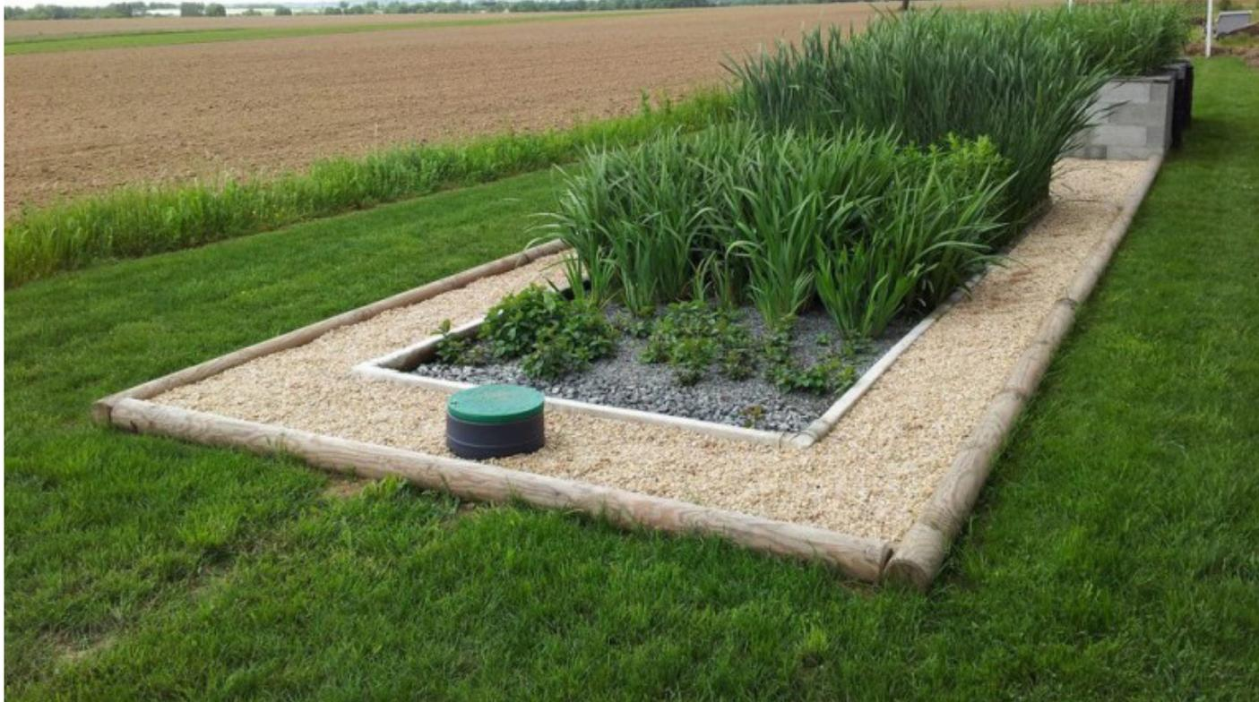
**Prétraitement** : filtre planté de roseaux à écoulement vertical (FV)
